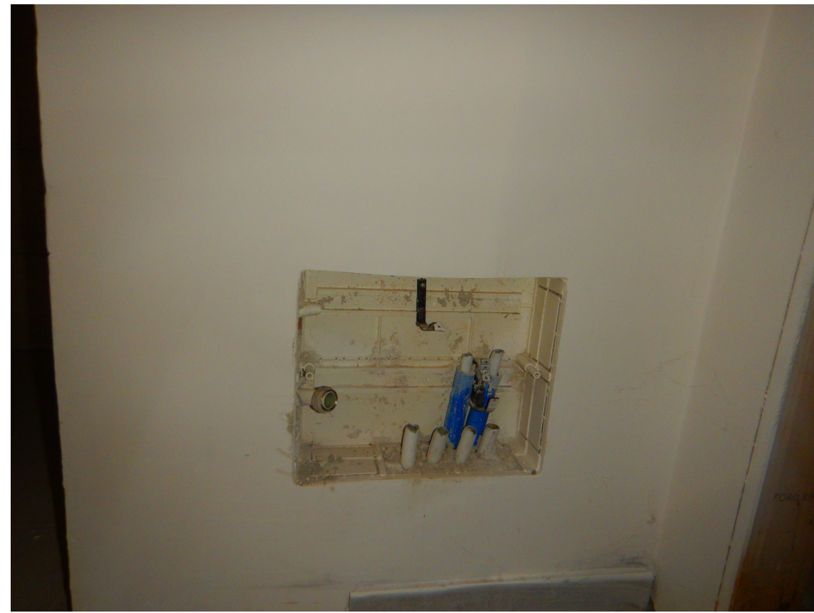
foto 7 - montare collettori e ripristinare collegamenti c.to sanitario
